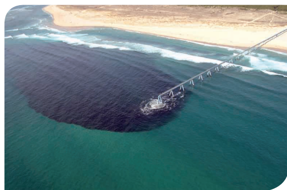
Rejets du wharf de la Salie (33) constitués des eaux usées, partiellement traitées, des habitants du Bassin et des rejets industriels de l'usine de papier Smurfit Kappa - © - Stéphane Scotto - 28 août 2006 4
