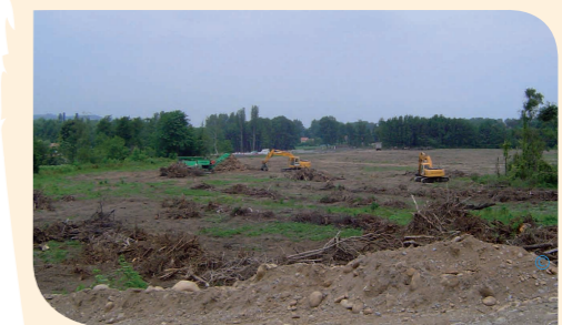
Zone humide défrichée sans autorisation pour l'aménagement d'un lotissement - (2008) St Jean du Falga (09) © Le Chabot
