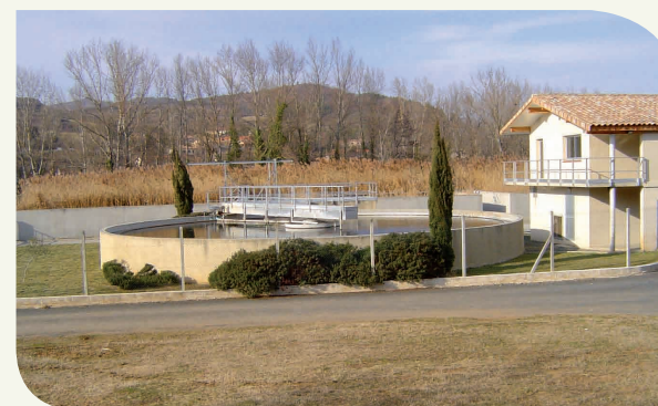
Station d'Espérasa associée à un filtre planté de phragmites (11) - © - Le Chabot
