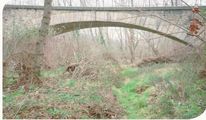
3ème arche du Pont de Bénagues (09) Débit insuffisant, le lit se referme (avant 2004)
