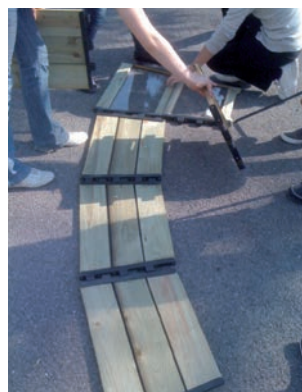
Construction d'un composteur dans le cadre de l'opération 3C (Compostage Cantine Collège), interrogeant la provenance des déchets - CPIE Alpes de Provence
