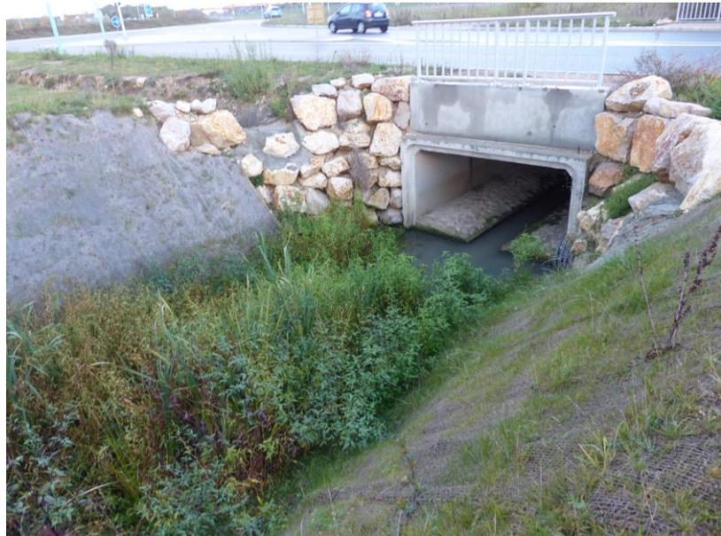
Il est proposé de faire des épis grâce à des enrochements afin de réduire la section du cours d'eau et récupérer un lit d'étiage en se calant notamment sur la section de l'ouvrage mis en place, d'apporter de la granulométrie (diamètre 0,1-0,15) et d'enlever la végétation installée.
