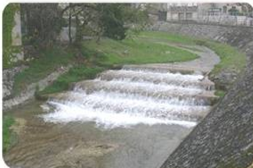
situation avant travaux
