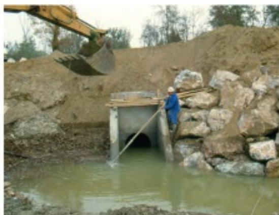
1987 Installation d'une prise d'eau à l'embouchure amont du bras du ramier et enrochements de protection (Photo P. Beaudelin)
