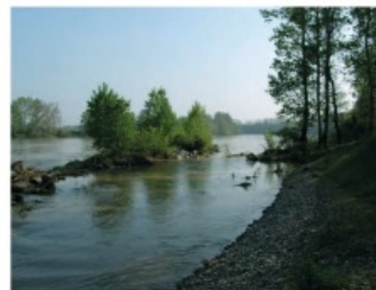
Après les crues de 2000, 2003 et 2004, les blocs (visibles à gauche de la photo) sont toujours présents. Les crues passent plus régulièrement à l'arrière des blocs, érodant à chaque fois le talus.
