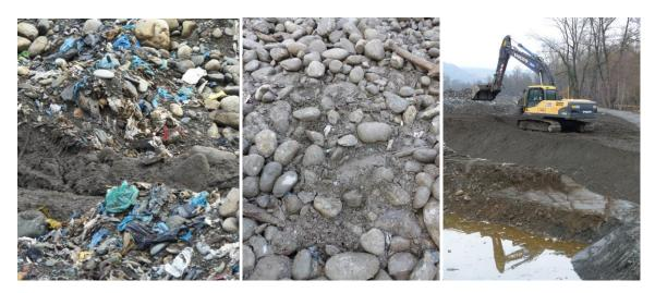
Concrètement, suite aux sondages, le pelliste délimite le casier en creusant autour, puis le contenu du casier est enlevé et traité sur site via une chaîne de machines de tri (granulométrie, poids, matières).
