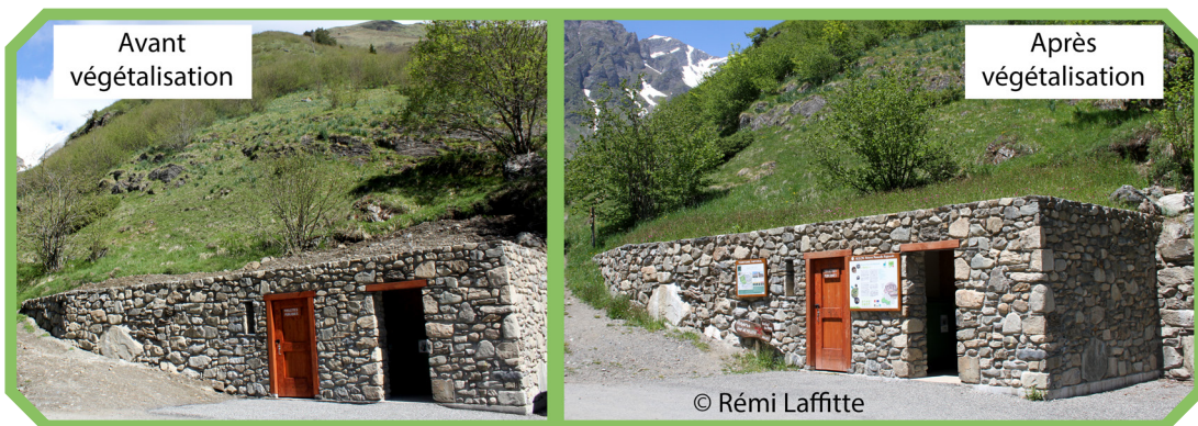
Bâtiment situé à l'entrée du sentier de la réserve naturelle d'Aulon.
