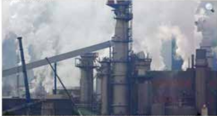
Pratiquement tout est en conformité désormais sur le site de Fibre Excellence. / Photo DDM, archives, JAL
