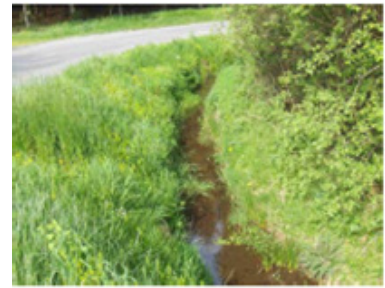
2. Cours d'eau déplacé (Le Margnès-81)
