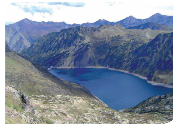
Barrage de Naguilhes (09) - 93 ha inondés - 43 millions de m 3
