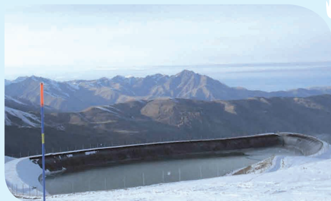
Retenue 66 000 m 3 , un point dur visuel - © - Jim Sorbé
