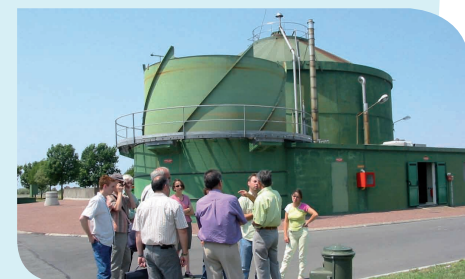
Station d'épuration de Rochefort (17) avec récupération de méthane © - Jacques Brie
