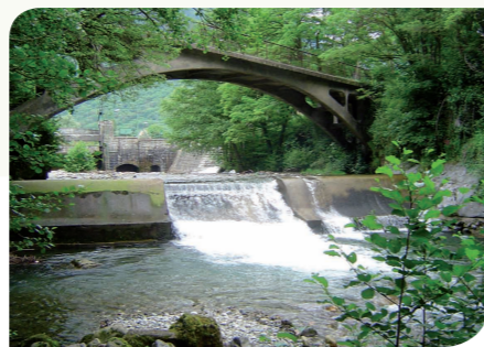
Le débit réservé du Vicdessos (09) après révision du droit d'eau
