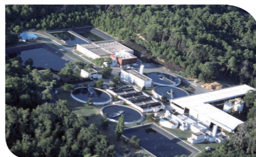
6/ Hydroplus – Traitement des eaux usées – N°184 – Novembre 2008 - p.40-41
