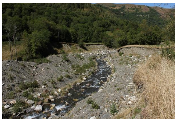
Photos : merlon et zone d'érosion suite à la crue de juin 2013 sur la Neste d'Oô
